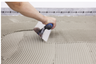
4. Klebemörtel, abgestimmt auf den Untergrund, mit einer 6 mm Zahnkelle auftragen und...
