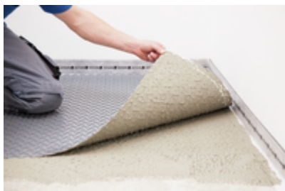
5. die bereits zugeschnittene ARDEX FLEXBONE® mit dem Vlies in die noch frische Klebemörtelschicht einbetten...
