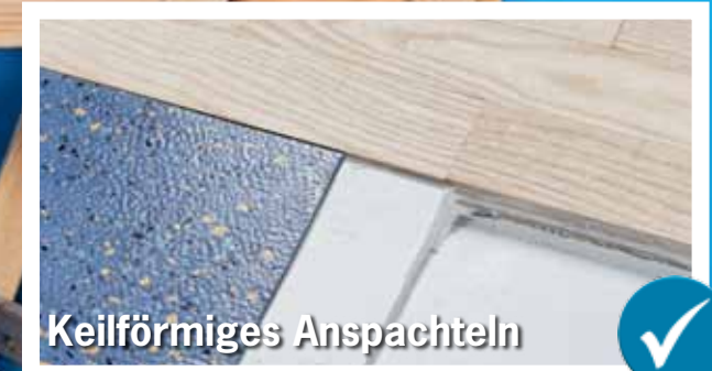
Verspachteln von Bodenplatten
