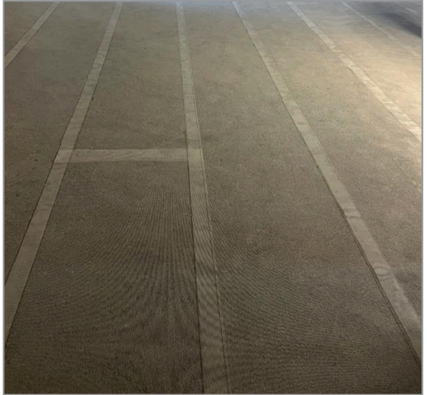
Mittwochs kam das lose und mit Überlappung verlegte Armierungsgewebe ARDEX BU-R auf die gebundene Leichtschüttung. „Das alkalibeständige Gewebe macht die Konstruktion extrem stabil“, erklärt Wolfgang Schwarz.
